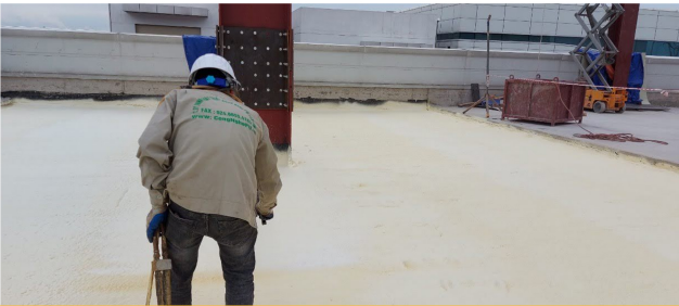
Phun cách nhiệt mái bê tông
